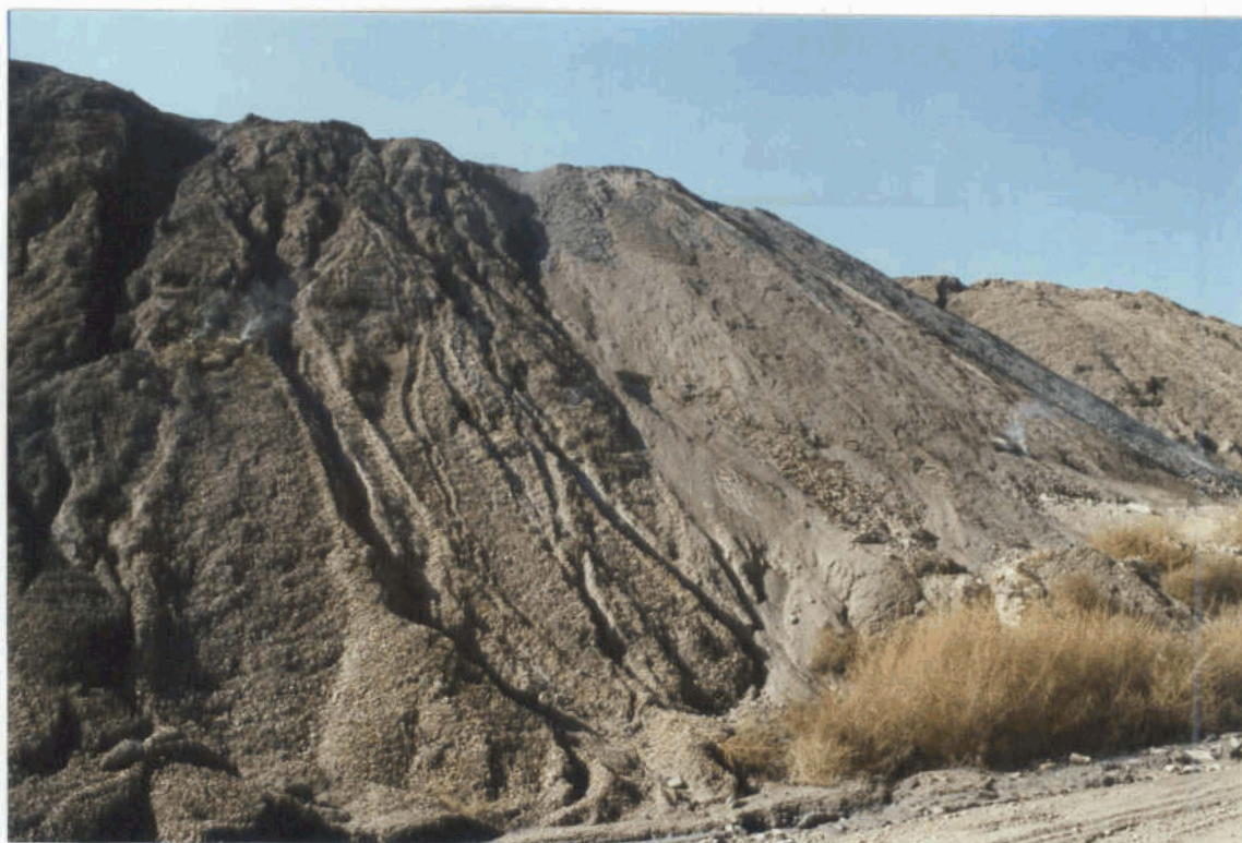
Fotografía 8.- Estructura 31-16-7-59. Detalle de fenómeno erosivos. Pueden verse varios puntos en autoignición.
