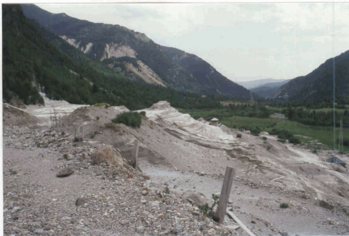
Fotografía 7.- Balsa de Bono (estructura 32-09-07-51). Detalle de los fenómenos de erosión y ruina parcial.
